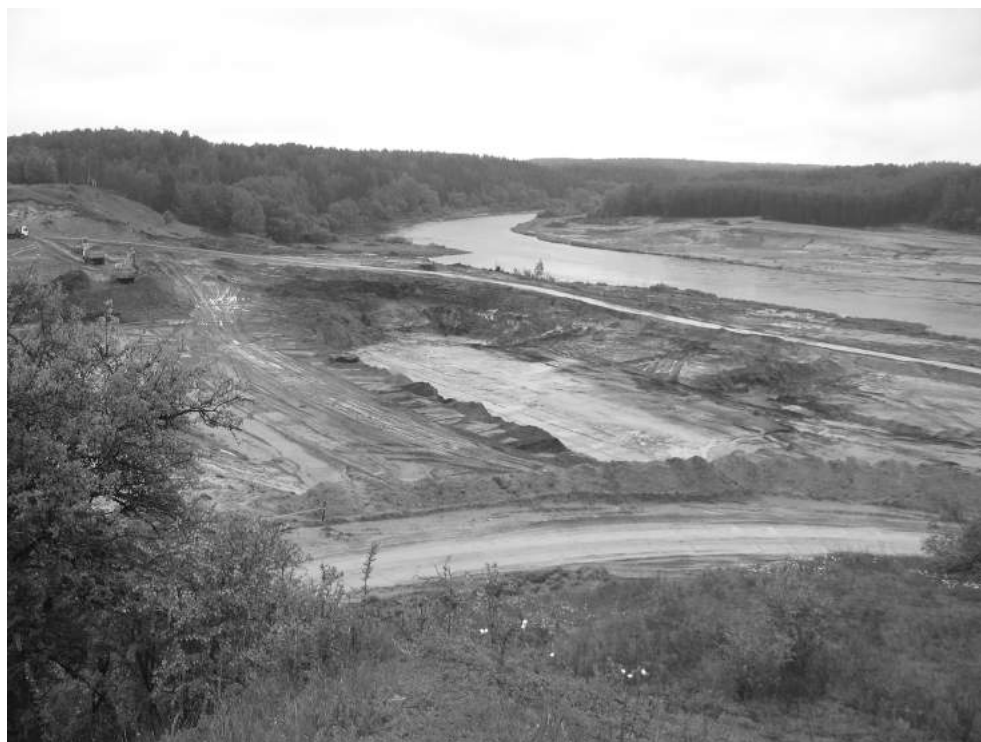
Рыс. 7. Зона будаўніцтва плаціны Гродзенскай ГЭС на р. Нёман каля вёсак Шчачынова і Жылічы. Пачатак земляных работ. Вясна 2008 г.
